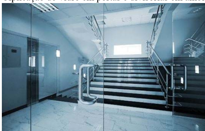
Figura 32 – Aplicação do vidro em portas e divisórias em ambientes indoor .
