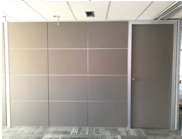
Figura 35 – Aplicação de MDF para divisória em ambiente indoor .
