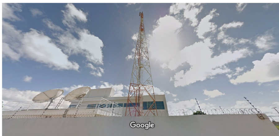
Figura 24 – Estação transmissora de TV digital (canal 47) em Mossoró - RN
