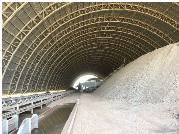
Figura 26:Pátio de pré-homogeneização Fonte: Autoria própria.
